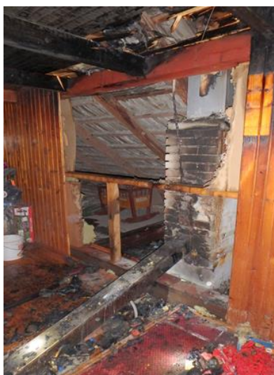
Trám prechádzajúci cez komínové teleso
